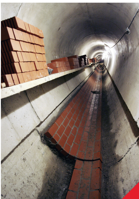
Köln, Rheinuferstraße Execuție radier canal colector ovoidal din clincher
