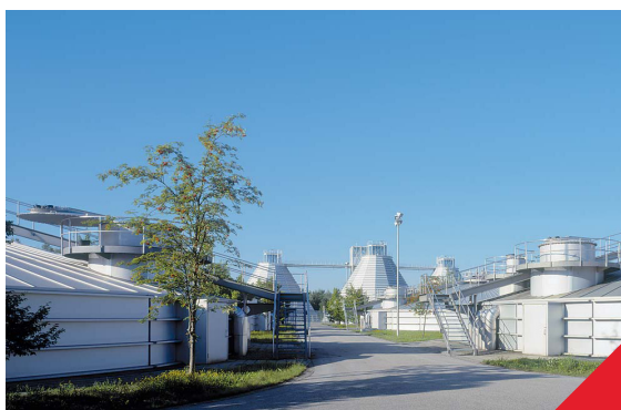
Stația de tratare a apelor uzate Gut Marienhof, din München
