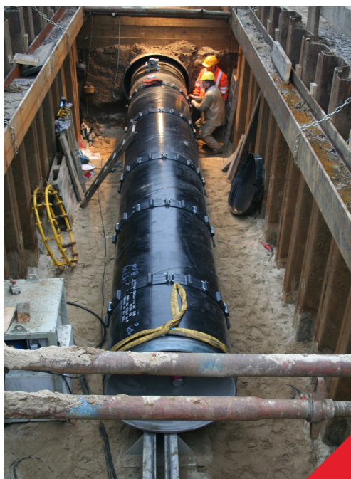
Berlin, Biesdorfer Promenade Execuție conductă alimentare cu apă din fontă DN 1200
